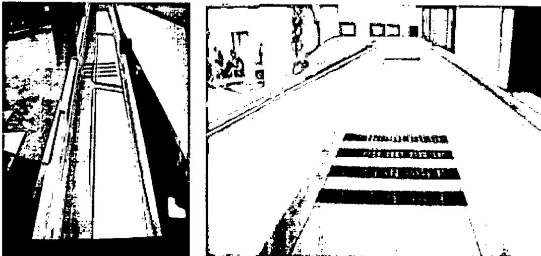
Figura 44.19 e 44.20 - Piso tátil direcional e de alerta em material plástico, colado no piso definitivo da rampa ao pavimento superior.
