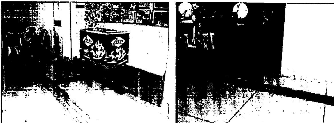
Figura 44.15 e 44.16 - Piso tátil direcional e de alerta em material plástico, colado no piso definitivo. O desgaste do material plástico pode causar acidentes.
