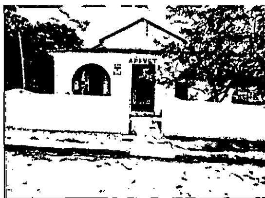
Figura 56.7 - fachada do ambulatório
