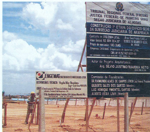
Obras do edifício-sede do Tribunal Regional Federal em Arapiraca
