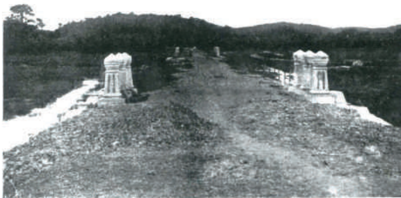
Camaragibe - Aterro do Bernardo Gomes
