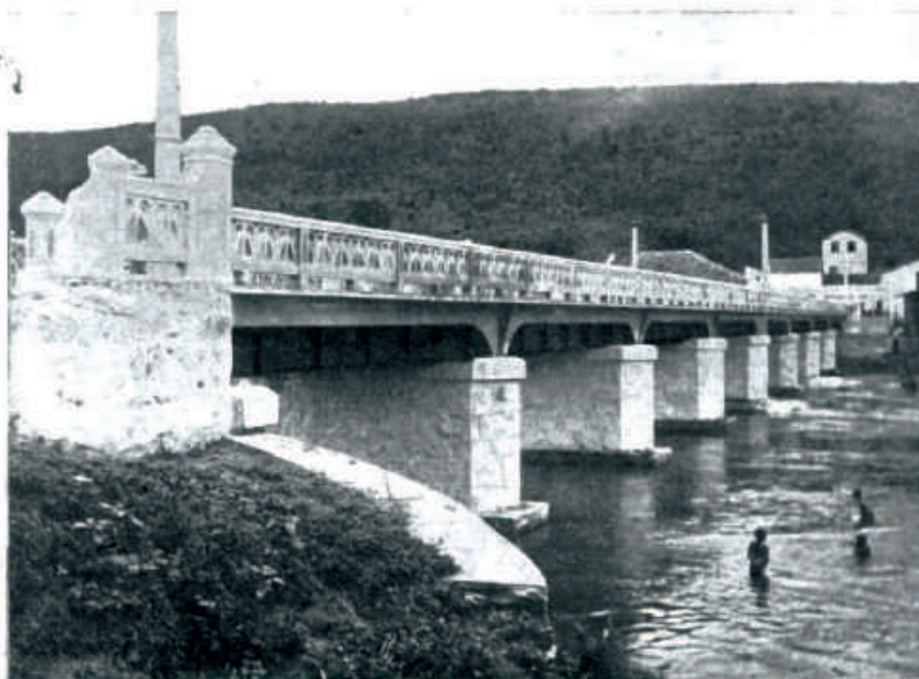
Viçosa - A grande ponte sobre o Parahyba
