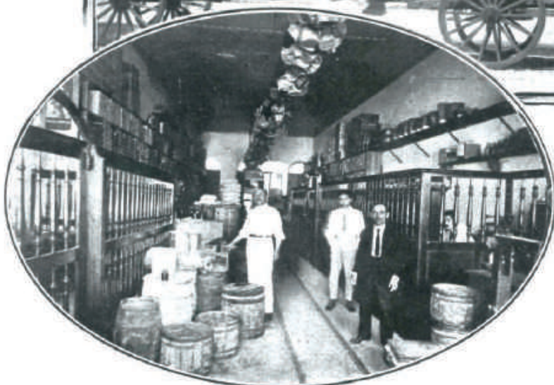
Fachada e interior da casa de Duque Amorim & C.
