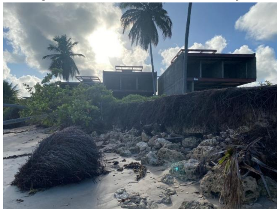
Figura 42 – Residencial em construção
