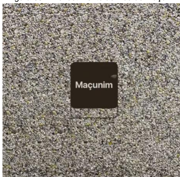
Figura 63 – Revestimento acrílico de maçonim
