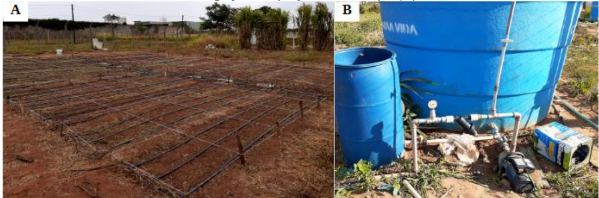
Figura 6 - Sistema de irrigação montado em campo (A) e reservatório de água utilizado para a irrigação do projeto em campo (B)
