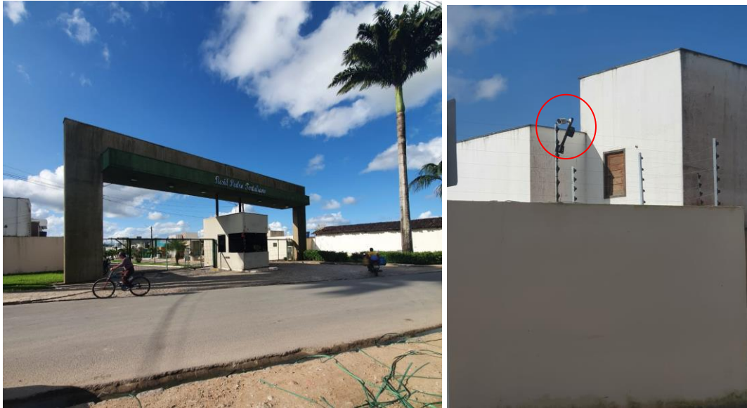
Figura 33 – Portaria do Residencial Pedro Tertuliano e câmeras de monitoramento no prolongamento do muro
