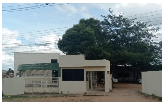
Figura 3 – Atual prédio da Unidade Palmeira
