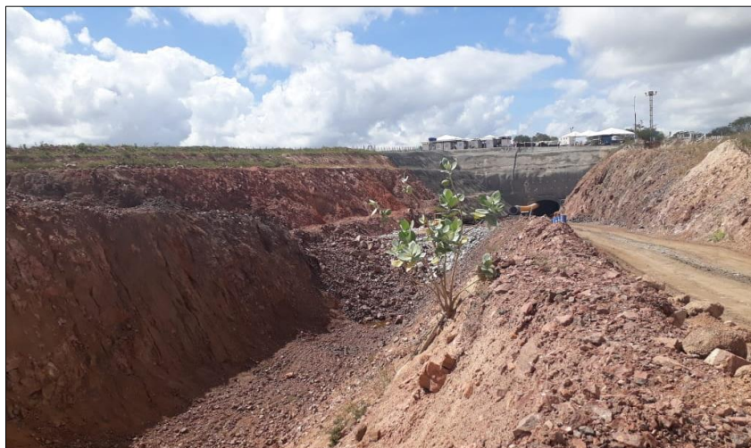
Imagem 10 - Túnel do Canal do Sertão
